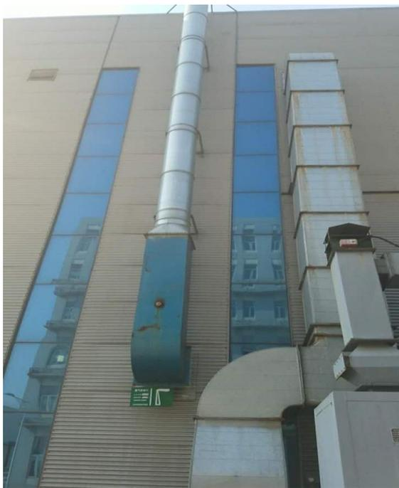
图 4-1 抛丸工序废气排放口 (P1)
