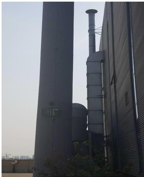
图 4-2 烘干炉与喷漆废气排放口 (P2)
